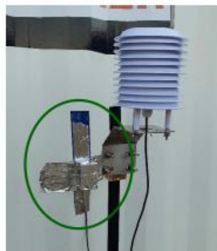
b. capteur de surface mise en place
