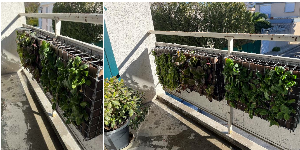
Figure 14. Cages végétalisées installés à l'intérieur d'un balcon
