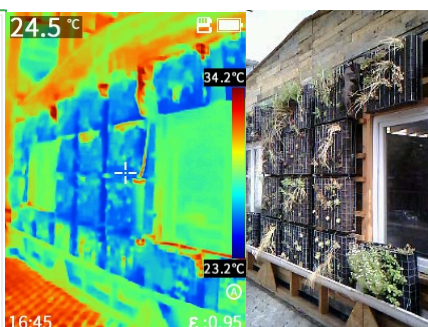
Photo thermique de l'Oasis
